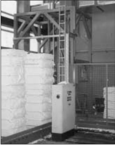
4 Flexibles Papierballenmagazin mit großer Staukapazität (mehrere Trailerladungen) für wirtschaftlichste Logistik ausgelegt.
