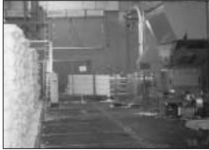
1 Ausstoß von der vollautomatischen Kanalballempresse auf den Beschleunigungsrollgang, kontinuierlich im Mehrschichtbetrieb, alle ca. 3 min. kommt ein Papierballen mit 300 kg, ins Abstapelungsgerät.
