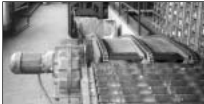
4 Ballenausschub/Transport mit Kettenförderer/Rollgänge in die vorgesehene Zwischenstapelbereiche/Lager.
